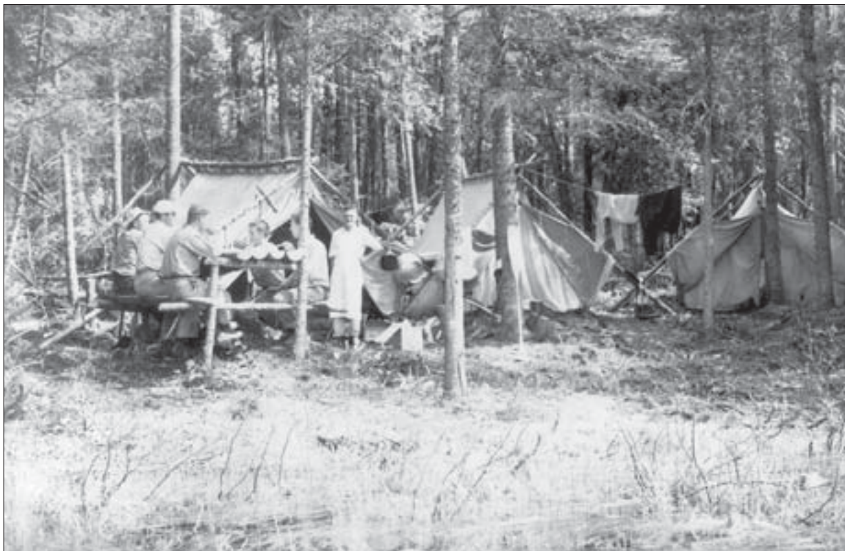
Une équipe d'arpenteurs et de représentants du gouvernement ontarien ont monté leur campement dans la région de la rivière Abitibi, au nord du 48e parallèle au courant de l'été. On estime que la région contient un potentiel hydro-électrique très important, en plus d'immenses ressources forestières et des gisements à découvrir qui pourraient contribuer à remplir les coffres de la province. (Musée Ron Morel)
